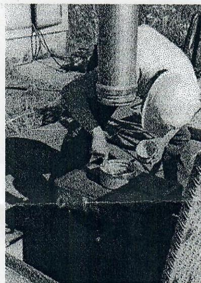
Einfetten der zugfesten Steckmuffenverbindung ZSM
